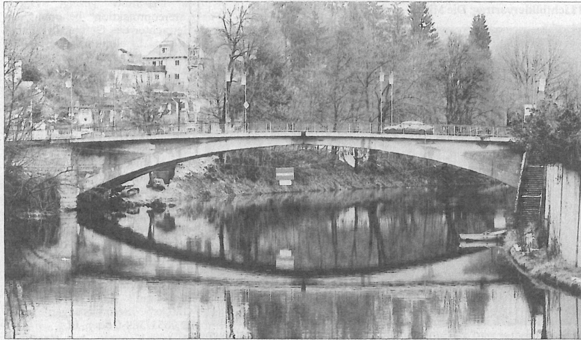
Die obere Ilzbrücke kommt weg, der Stau ist vorprogrammiert. Heute beginnen die Arbeiten. – Foto: Geisler
